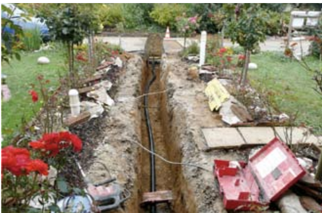
Grabungsarbeiten für den Hausanschluss sind auch auf sensiblen Grundstücken problemlos möglich. The digging work required for house connections is easily possible even in sensitive areas.
